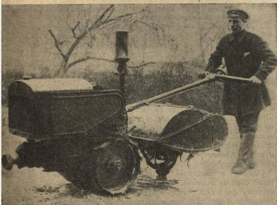
Среднеазиатский машиноиспытательный ин-т в Ташкенте. Испыта- ние сильной фрезы для хлопководства.
