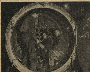
На Коломенском заводе. В котельной
