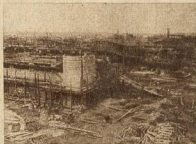
В БОРКХАХ СТРОИТСЯ ГОРНО-ТЕХНИЧ. УЧИЛИЩЕ
