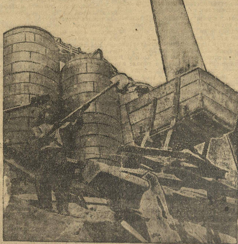
НА СНИМКЕ: ударник-землекоп из бригады Шеремешева (выполняющей задание на 135 проц.), на земляных работах у доменных печей.
