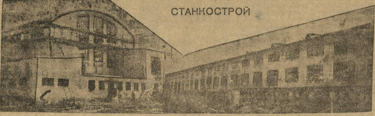
Котельная (слева) и главный корпус строительства.
