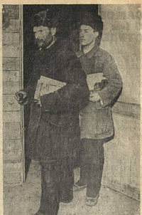
Рабочие строители идут в линпунт
