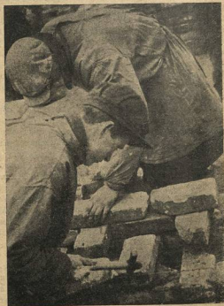
ФОТО Е. ИГНАТОВИЧ УЧЕБНО-СТРОИТЕЛЬНЫЙ ПУНКТ НА ДНЕПРОСТРОЕ ПРАКТИЧЕСКИЕ ЗАНЯТИЯ УДАРНИКОВ
