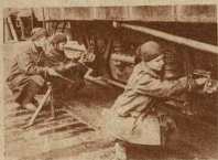
МИНТОВЦЫ РЕМОНТИРУЮТ ВАГОН
