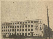
БАКУ НОВОЕ ЗДАНИЕ НЕФТЯНОГО ИНСТИТУТА
