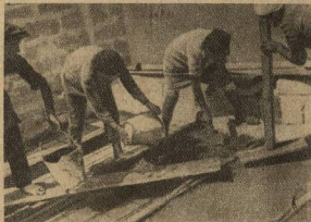
МЕРЧЕНСКИЙ ЗАВОД ИМ. ВОЙКОВА БЕТОННЫЕ РАБОТЫ СТУДЕНТОВ СИМ- ФЕРОПОЛЬСКОГО СТРОИТ. ТЕХНИКУМА
