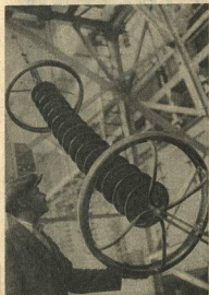
ИСПЫТАНИЕ ВЫСОКОВОЛЬТНЫХ ИЗОЛЯТОРОВ ДЛЯ СВИРСКОЙ ГЭС В ЛЕНИНГРАДСКОМ ЭЛЕКТРОИНСТИТУТЕ. ЛАБОРАТОРИЯ ИНСТИТУТА ПРОВОДИТ ИСПЫТАНИЯ НА НАПРЯЖЕНИЯМИ ДО МИЛЛИОНА ВОЛЬТ
