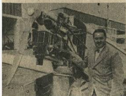
ГЕРМАНСКИЙ ПИЛОТ ХИРТ У СКОНСТРУИРОВАННОГО ИМ МОТОРА ВОЗДУШНОГО ХЛАЖДЕНИЯ. 4-х ЦИЛИНДРОВЫЙ МОТОР, где звездообразное расположение цилиндров заменено вертикальным. ДАЕТ 18% ЭКОНОМИИ ГОРЮЧЕГО
