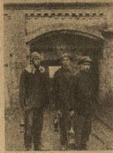
Из обследования 1 Ленинградского энергетического техникума бригадой «Красное студенчество».
