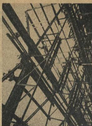
МОНТАЖ ФЕРМ КРЫШИ ЧУГУННО-ЛИТЕЙНОЙ КОЛОМЕНСКОГО ЗАВОДА
