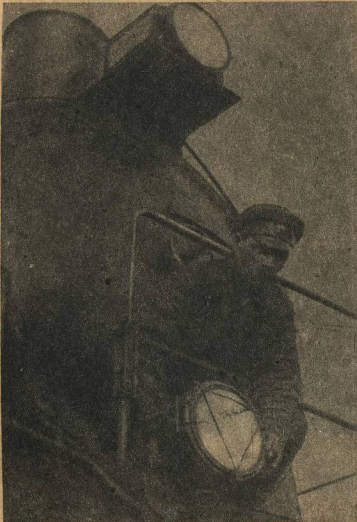
УСТАНОВКА ЭЛЕКТРО-ФОНАРЕЙ НА ПАРОВОЗЕ
