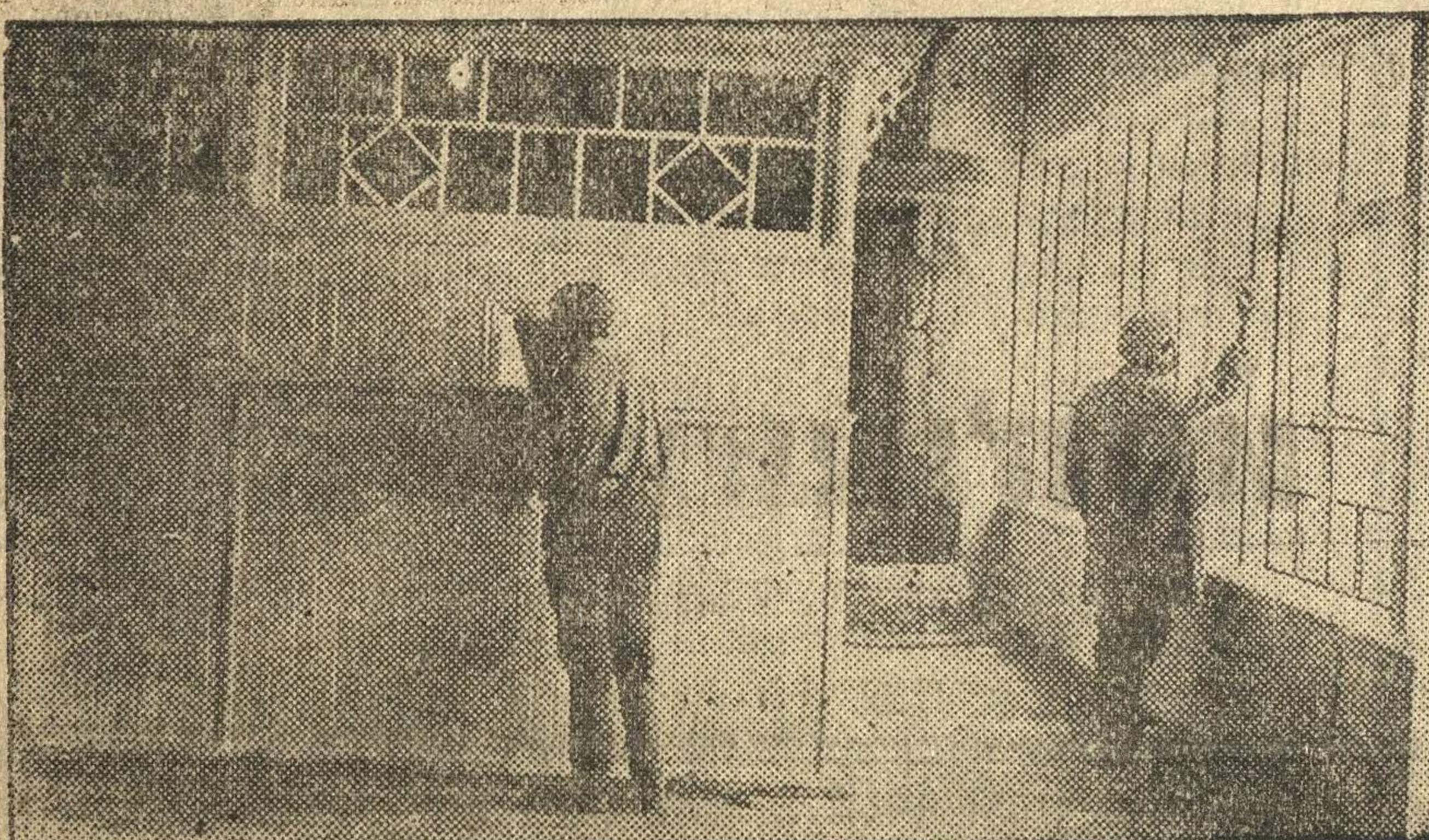
Производится оборудование вокзала ВУРГА.
