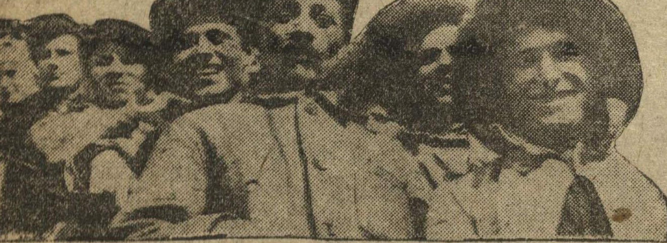
Ударники коммунистическая бригада каменщиков т. Смолыникова идет на площадке впереди других бригад; внесла 78 рабочих предложений.
