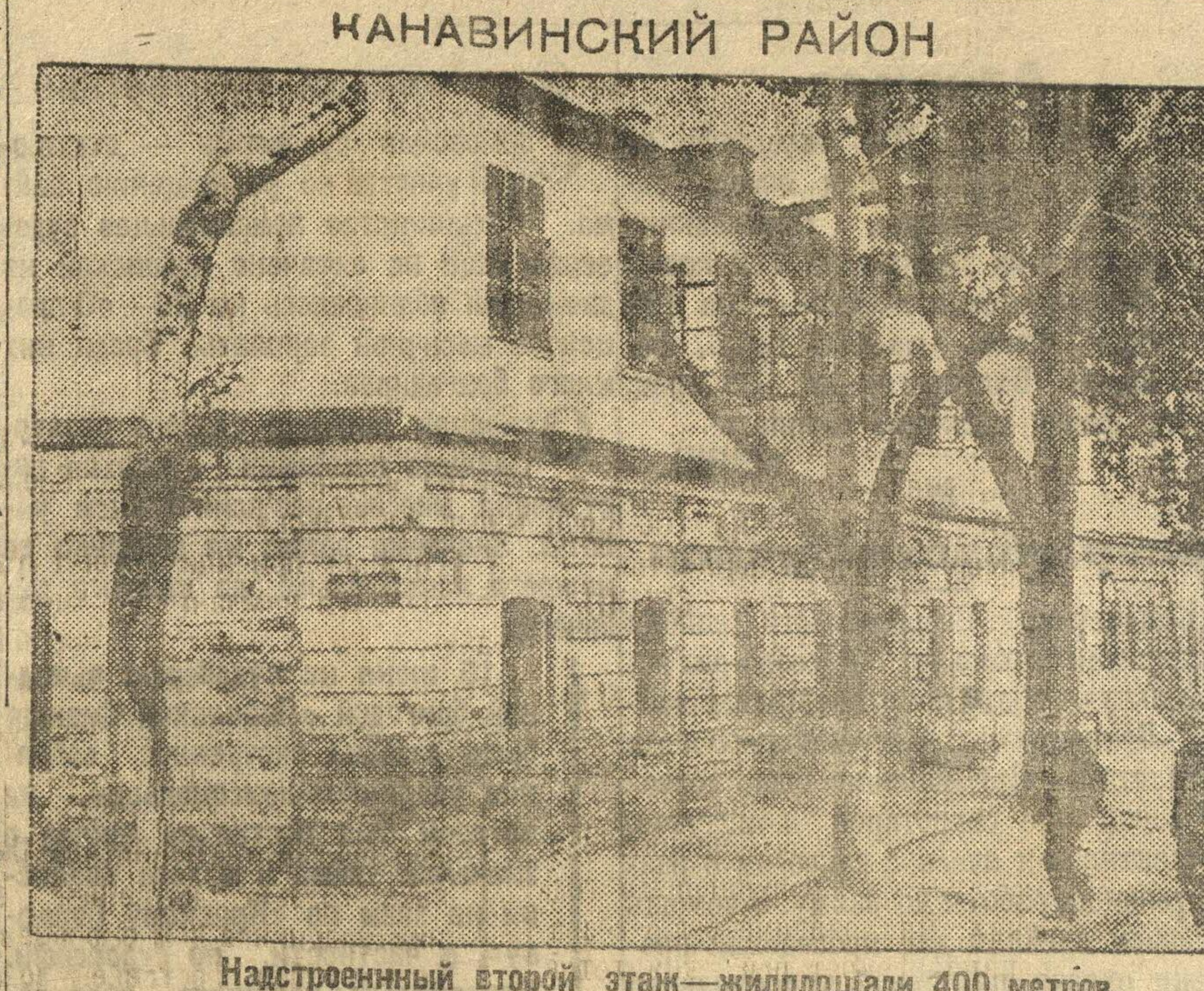
Надстроенный второй этаж — жилплощади 400 метров.
