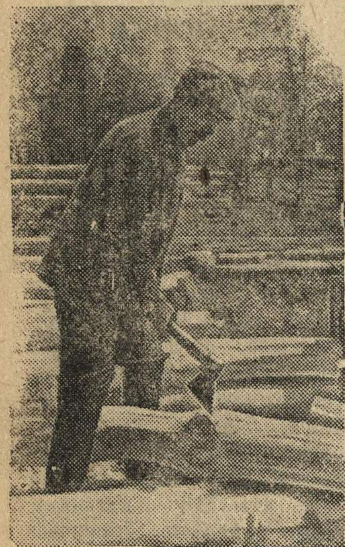
Колхозник дер. Редькино Я. Г. Захаров строит новую избу.
