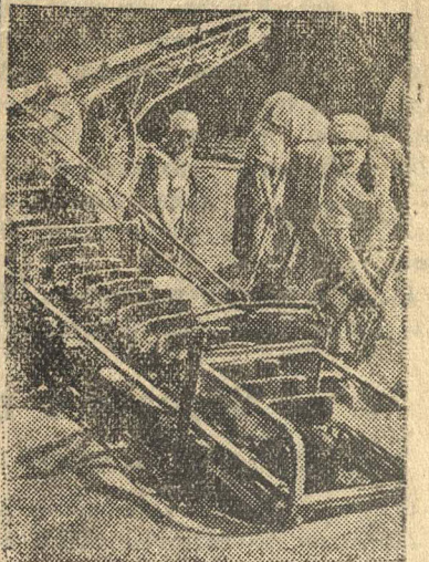
Разоренный во время немецко-фашистского нашествия элеватор станции Выселки, Краснодарского края, вновь восстановлен и ведет массовую приемку и отправку зерна. На снимке: механизированная погрузка зерна в вагоны. Фото П. Кальницкого. Фотохроника ТАСС.
