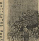
НА СНИМКЕ: Бойцы Н-Ф. Якуба, Ф. Е. Букин и Н. Я. Кувшинов в прифронтовой зоне Сталинградского фронта ремонтируют крышу хаты семьи красноармейца Д. Степанова. Фото Е. Ковалева. Фотографик ТАСС
