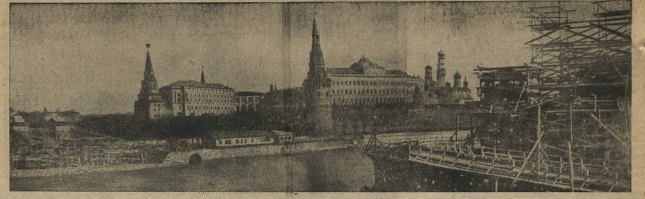
Строительство нового моста через Москва-реку на старом Ивановском мосту.
