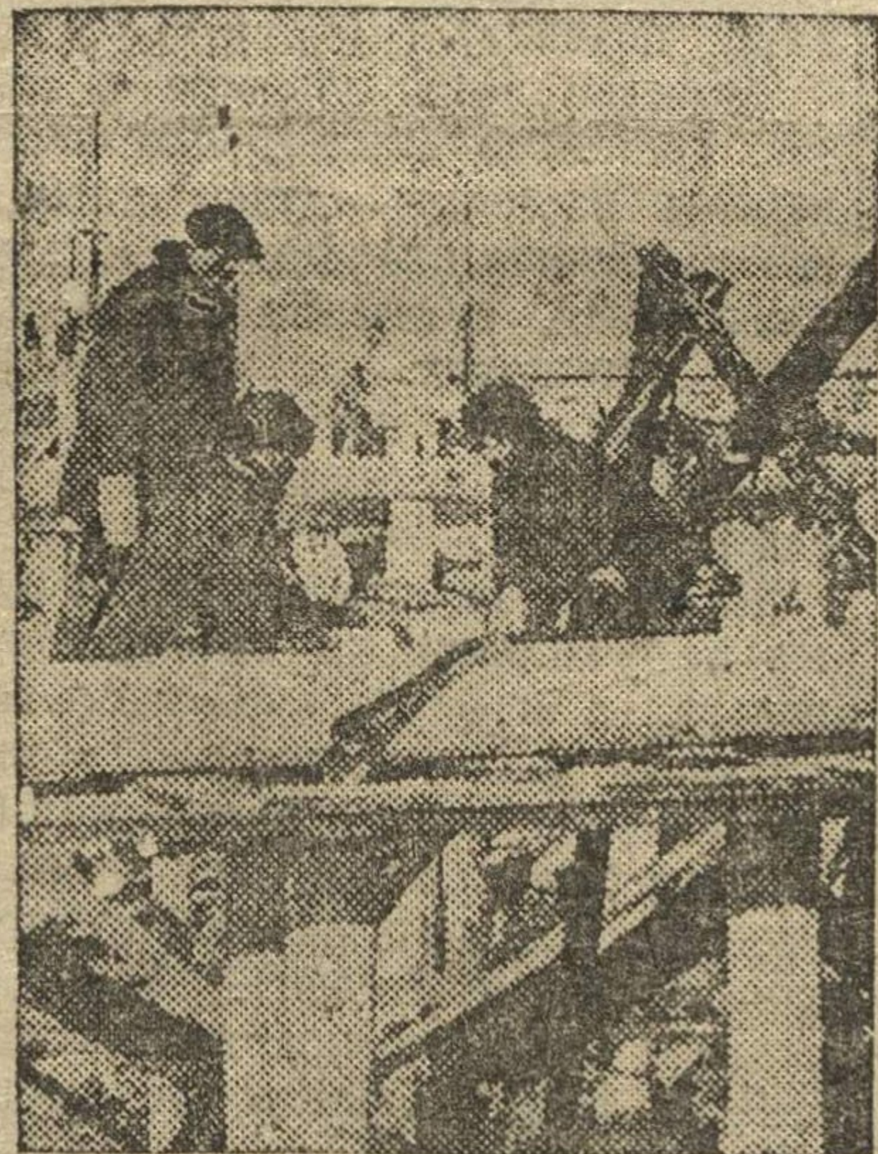
Крайдортранс производит постройку моста через реку Кудьма по тракту Горький—Казань. НА СНИМКЕ: укладка насадок плотниками БРИТОВСКИМ, МЕЖЕНИНОВЫМ В. и МЕЖЕНИНОВЫМ И.
