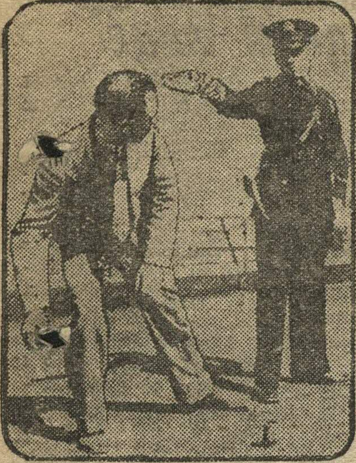
На снимке: миниатюрный киноаппарат, соединенный с револьвером, производит съемку одновременно с прицеливанием. Такими аппаратами снабжена полиция в Лос-Анжелосе.
