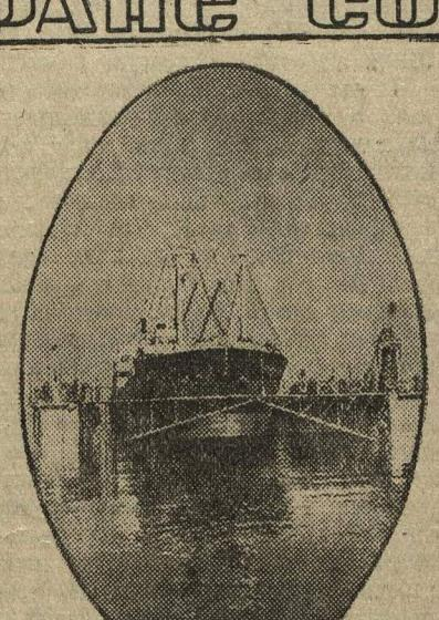
В Ленинграде закончена постройка большого пловучего железобетонного дока мощностью в шесть тысяч тонн. На снимке: общий вид нового дока с первым пароходом. (Фотохроника ТАСС).
