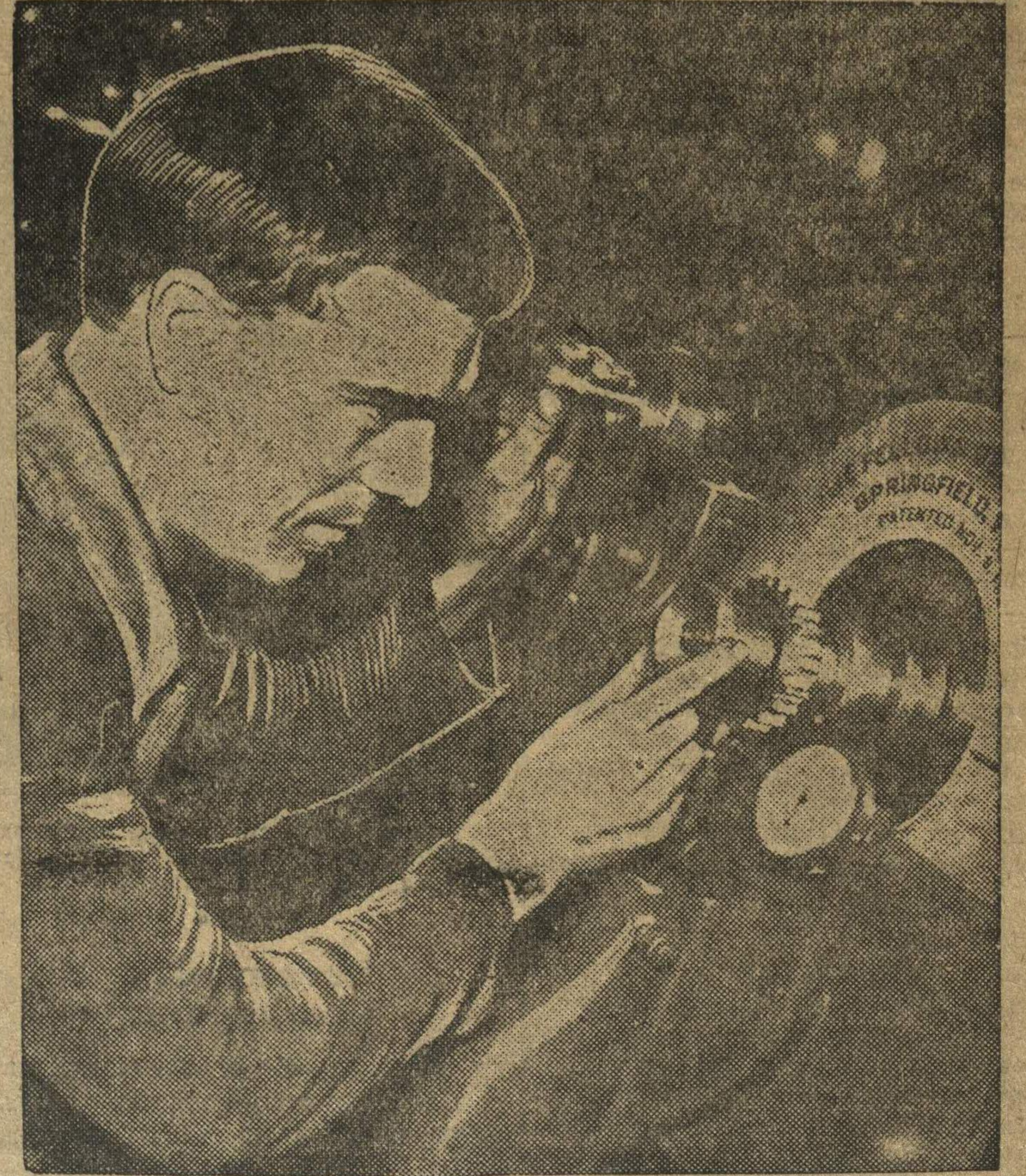
Комсомолец-бусыгинец, шпифовщик инструментального цеха, ФИЛИМОНОВ ФЕДЯ за проверкой долбяка на измерительном приборе. Норму он выполняет на 250—300 процентов (автозавод им. Молотова).
