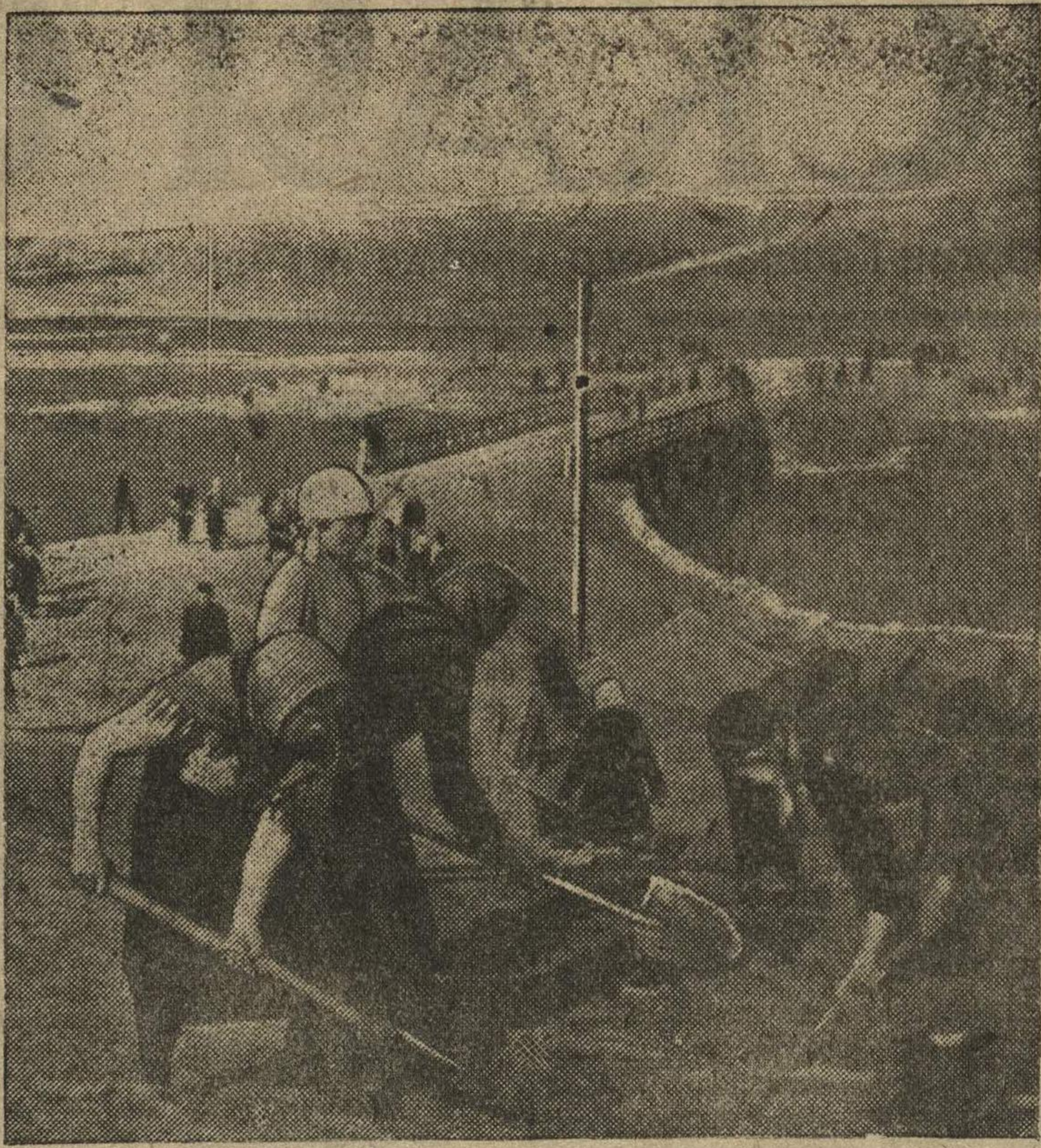
Строительство дороги Горький—Муром—Кулебаки. На снимке: земляные работы по созданию дамбы у Лоханского моста. Фото Г. Иванова.
