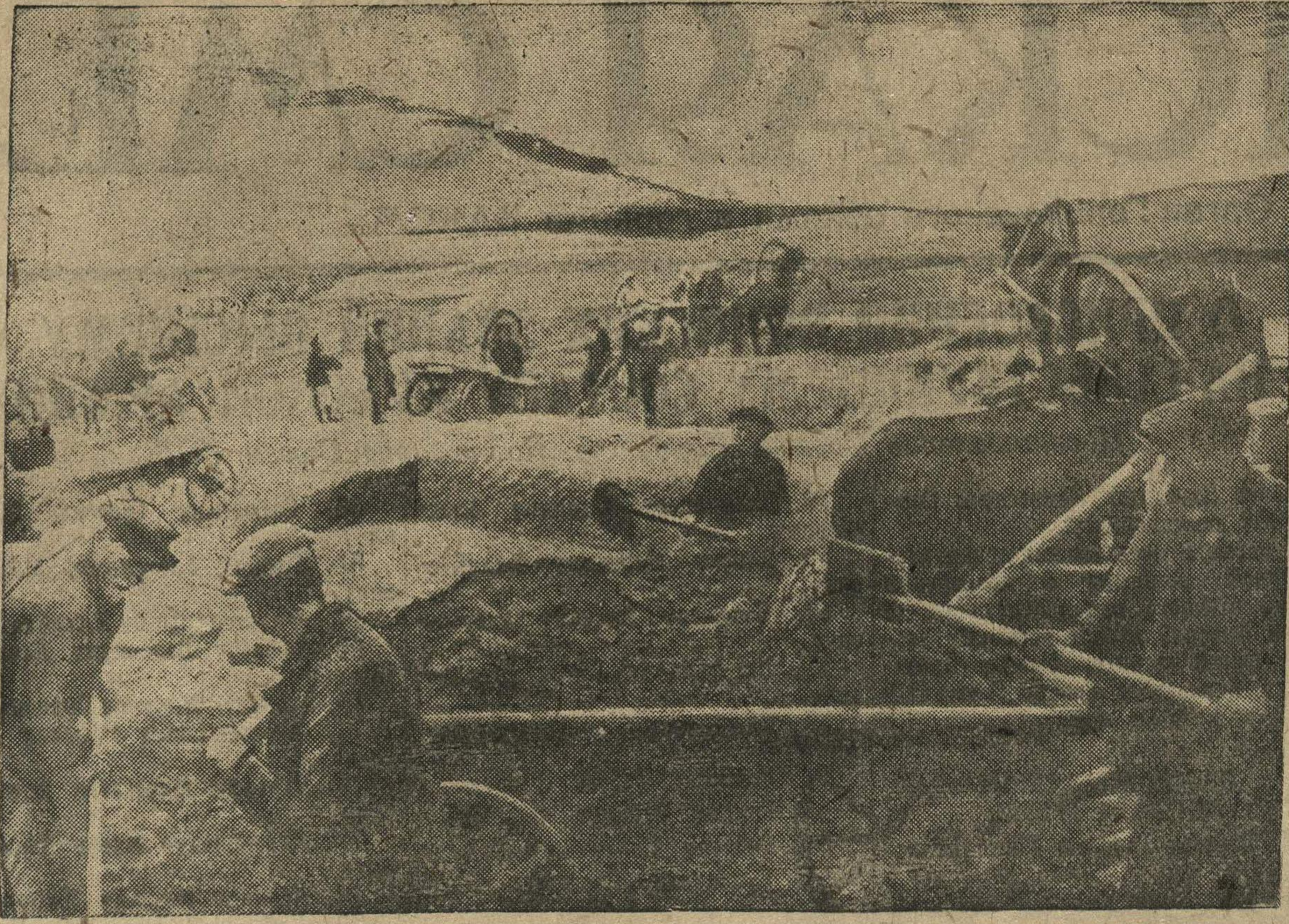
На строительстве дороги Горький—Муром—Кулебани. Колхозники колхоза «Осваивахим» производят выемку грунта с Сартаковской горы Богородского района.
