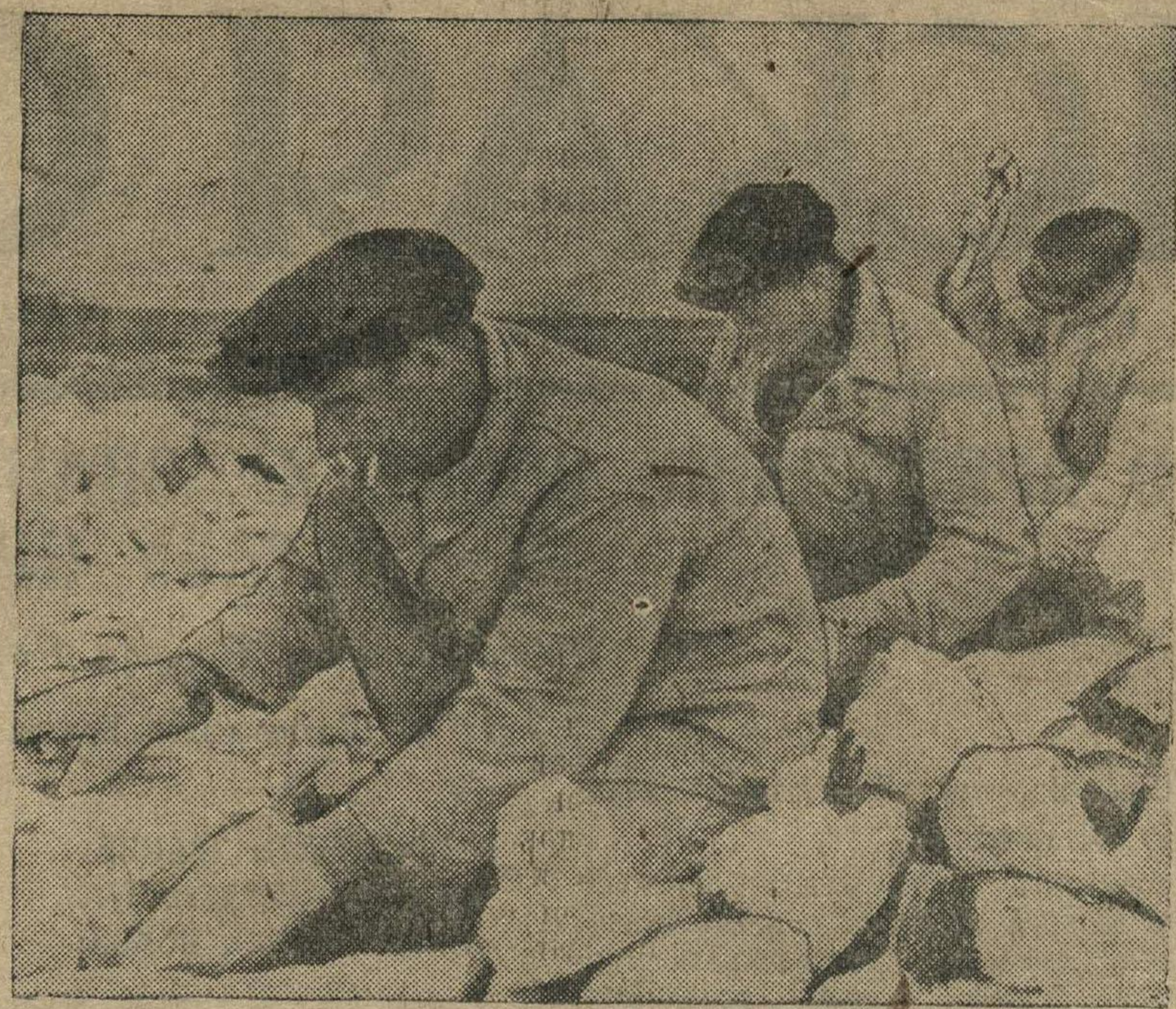
На строительстве дороги Горький — Муром — Кулебаки. На снимке: бригада мостовщиков т. Морозова (Богородский район) приступила к мощению проезжей части дороги.
