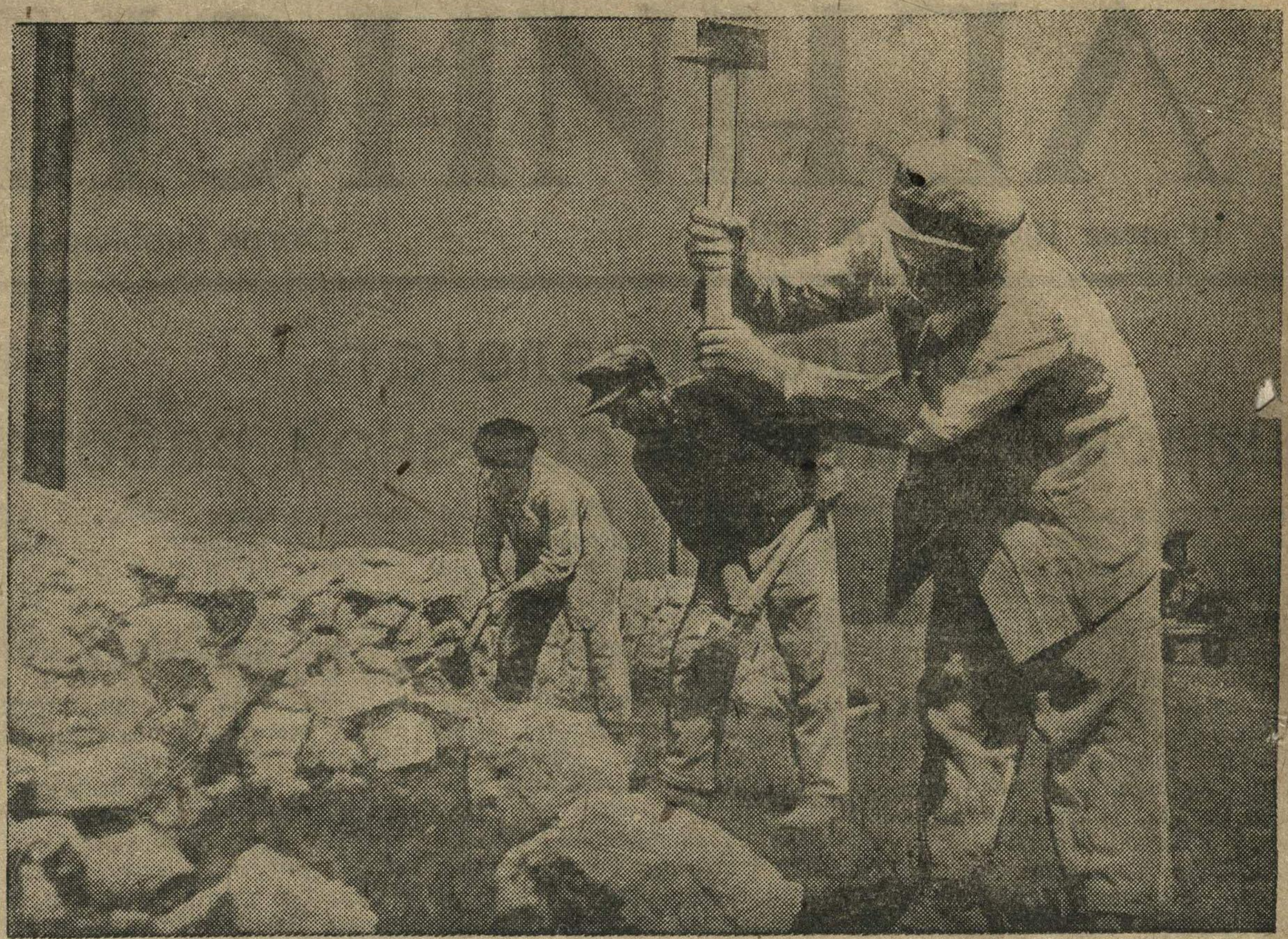
На строительстве дороги Горький—Муром—Кулебаки. Бригада мостовщиков И. В. Квасова (Богородский район) за подготовкой камня для мощения дороги. Фото П. Вознесенского.
