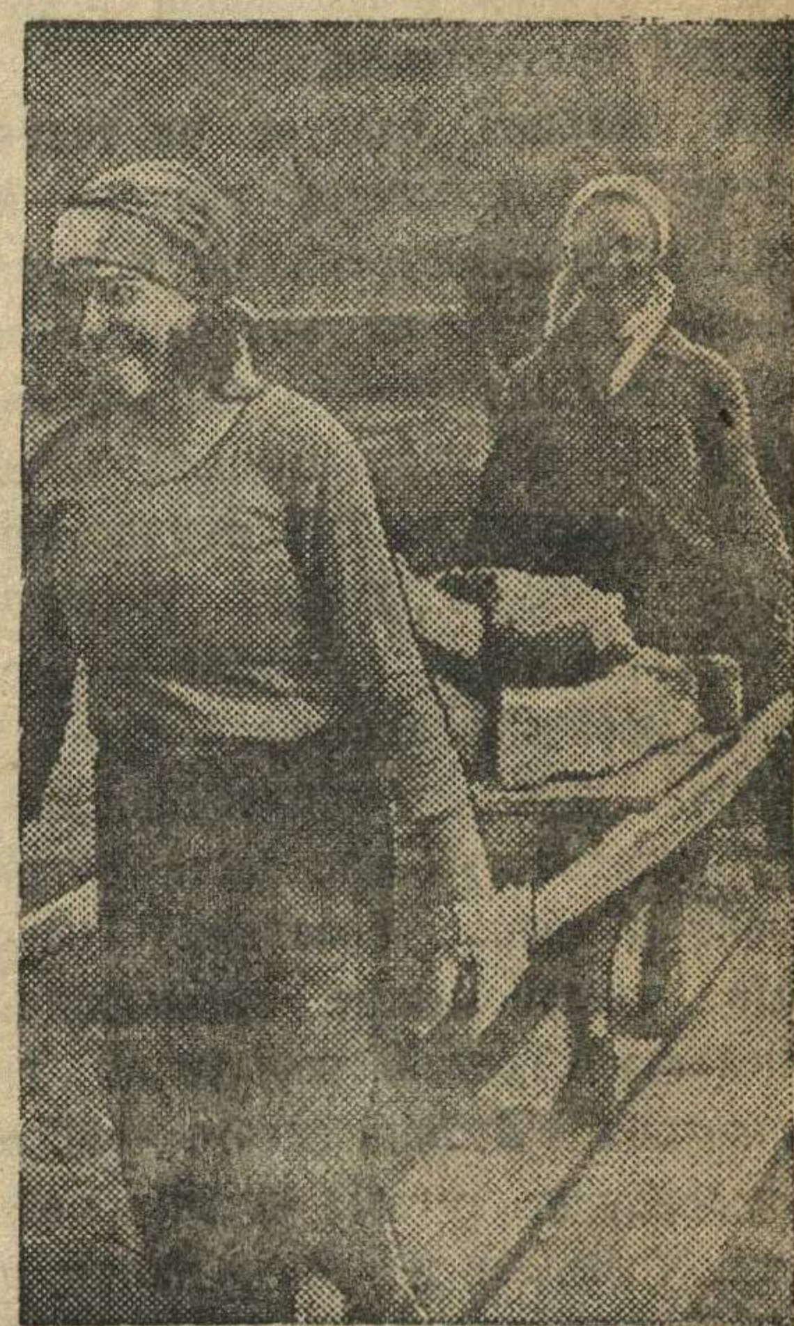
На строительстве дороги Горький — Муром — Кулебаки. На снимке: женская стхановская бригада Шубиной (Богородский район) за подноscopic намна для мощения дороги. Фото П. Александрова.
