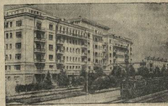
Новый жилой дом металлургов Кузнецкого завода имени Сталина (гор. Сталинец, Кузбасс). Фото И. Александрова.
