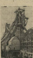
Путенная работа после реконструкции цеха № 3 завода им. В. Куйбышева (Брама-торса). Мощность цеха доведена до 650 тонн чугуна в сутки.
