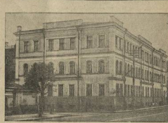
Здание школы № 11 по Большой Брдынке (Мескв), отведенное под ремесленное училище сталестроительного завода имени С. Орджоникидзе. Фото П. Игнатенко.
