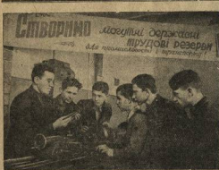
Мастер фрезерного дела ремесленного училища № 8 в г. Кисе В. М. Дробот объясняет ученикам значение головки вертикального фрезерного станка.
