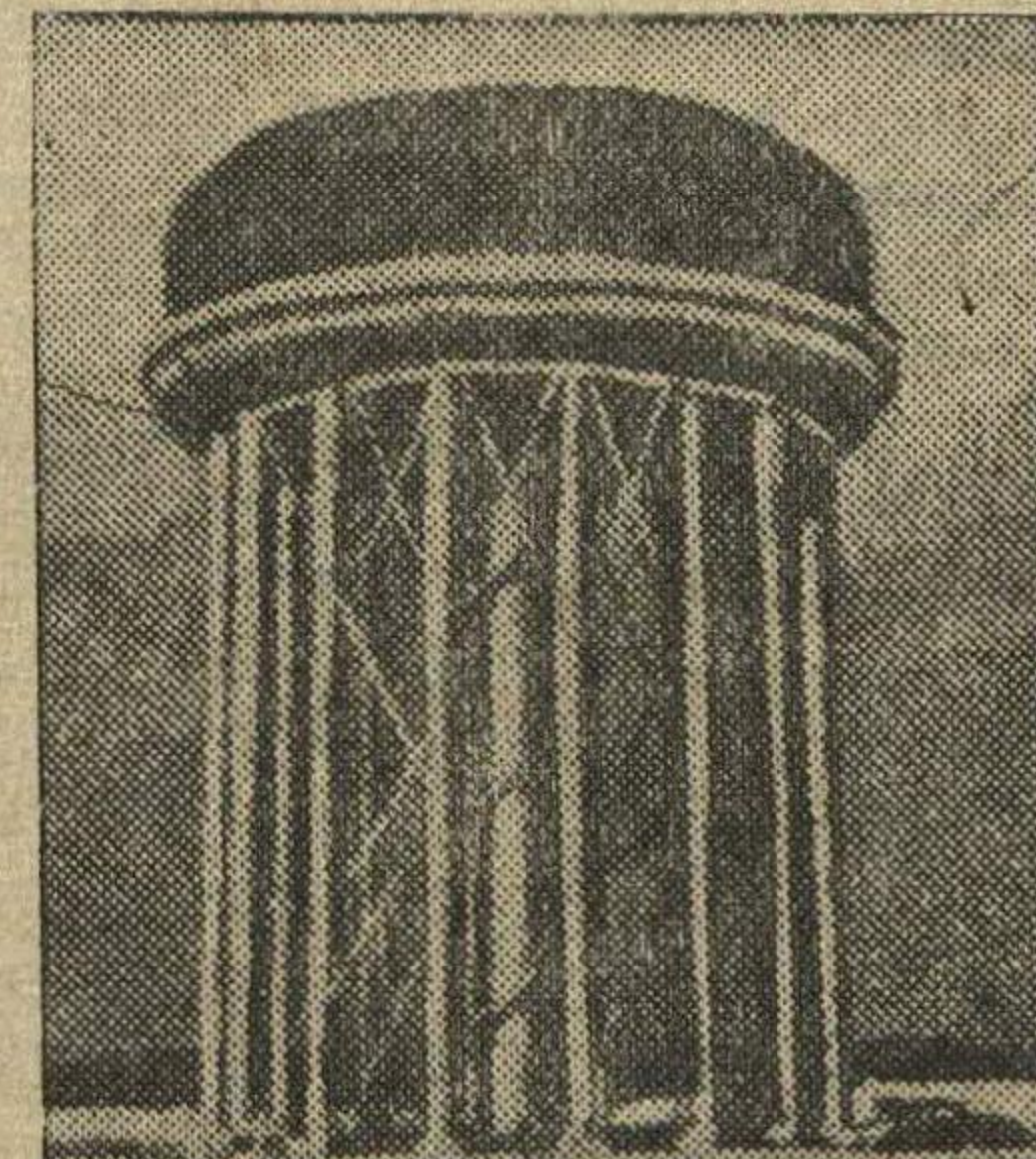
Крупнейшая водонапорная башня построена для водоснабжения города Гэксона (США). Вместимость ее — около 4 млн. литров воды, высота — 36 м. Башня цельносварная и сделана из стальных плит толщиной от 6 до 12 мм.
