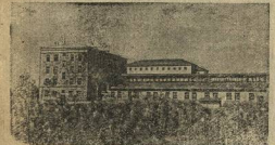
В Челябинске открывается ремесленное училище, которое будет готовить квалифицированных рабочих для металлургической и металлообрабатывающей промышленности. Для училища построено новое здание.
