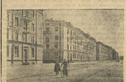
МЕМЕРОВСКАЯ ОБЛАСТЬ. В городе металлургов—Станиславском строительство жилых домов. На снимке: новые дома на проспекте имени Молотова.
