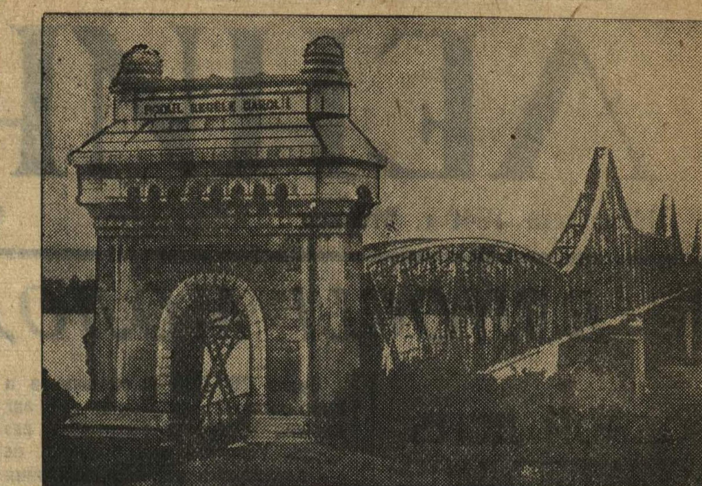
Румынский железнодорожный мост через реку Дунай у станции Черноводы, разрушенный советской авиацией 11 августа.
