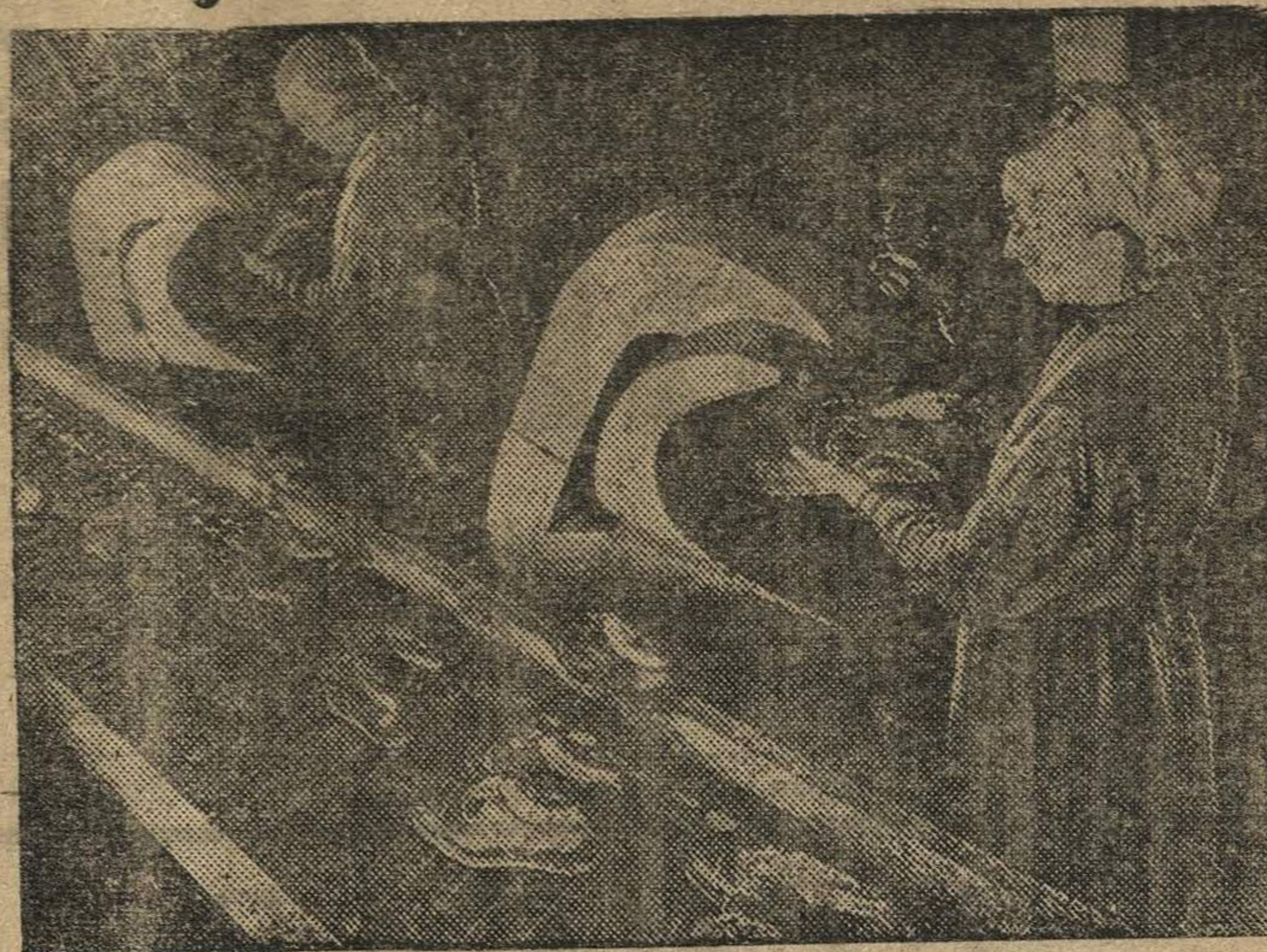
Фрезеровка рантов на Московской обувной фабрике «Парижская коммуна».
