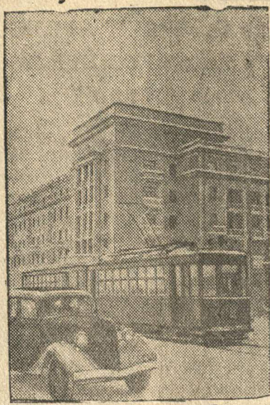
Вновь построенная гостиница по улице Ленина в Уфе (Башкирская АССР). Фото В. Бутчирова. Фото ТАСС.
