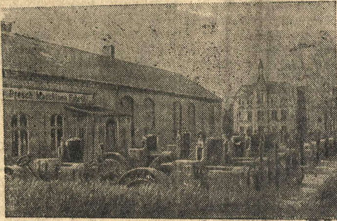
Восточная Пруссия. Газогенераторные тракторы, захваченные советскими войсками на машиностроительном заводе Вальтера Преш в городе Хайльсберг.
