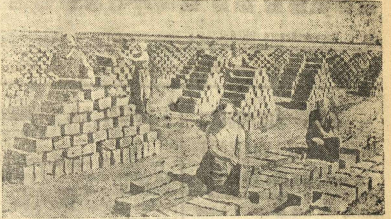
На снимке: колхозная бригада за изготовлением саманного кирпича. Фото И. Дынина. Фотохроника ТАСС.
