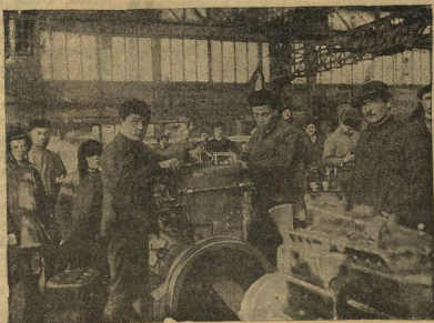
Работа моряков по ремонту двигателя.
