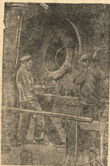
Восстановление Езакитского металлургического завода. Ремонт доменной печи. Фото Д. Фавловича Хотохроника ТАСС
