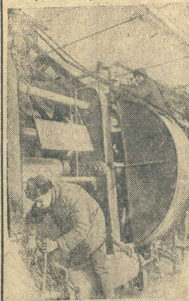
Монтируются машины и агрегаты в восстанавливаемом цехе ситценабивной фабрики „Пролетарка“ Фото Г. Петрусова Фотохроника ТАСС
