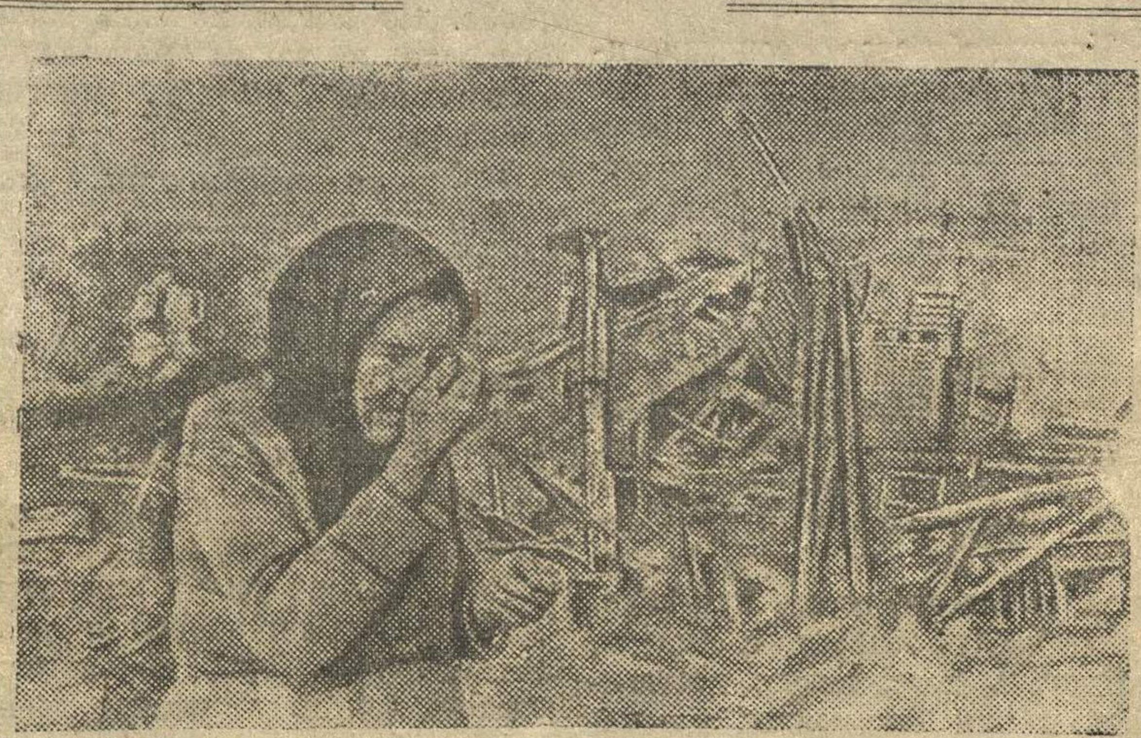
ВОЛХОВСКИЙ ФРОНТ. На снимке: 75-летняя Дарья Ивановна Черепанова у разрушенного гитлеровцами дома.
