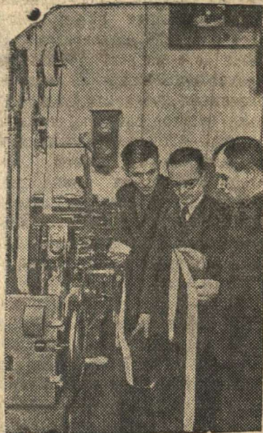
Рыбинский завод полиграфических машин сконструировал и изготовил скоростными методами первую в Союзе лентопечатную машину для «говорящей бумаги». На снимке: испытание новой машины.
