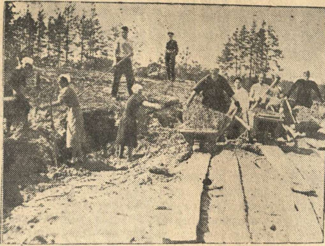
Трудающиеся гор. Кулебак энергично помогают колхозникам строить народную магистраль Горький—Арзамас—Кулебаки. На снимке: бригада работников Кулебацкого отделения Госбанка на земляных работах на участке Сонинского колхоза.
