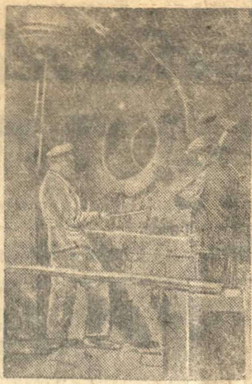
Восстановление Благоевского металлургического завода. Ремонт доменной печи.
