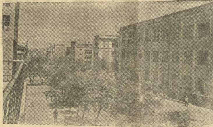
Жители города Сталино (Донбасс) залечивают раны, нанесенные городу гитлеровскими захватчиками. На снимке: восстановленные дома по улице имени Артема.
