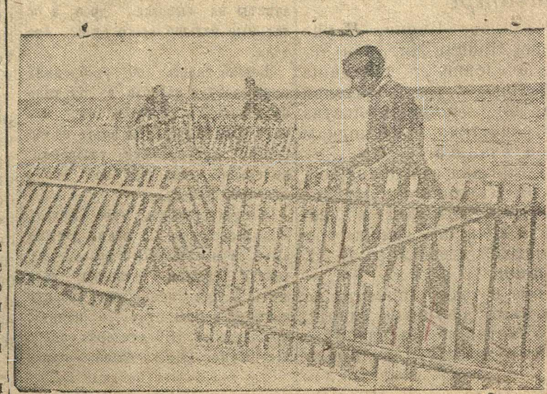
Расстановка щитов для снегозадержания.
